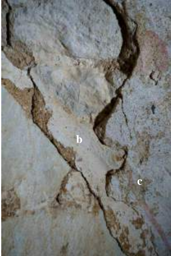
Détail de l'enduit c recouvrant l'enduit b précédent
