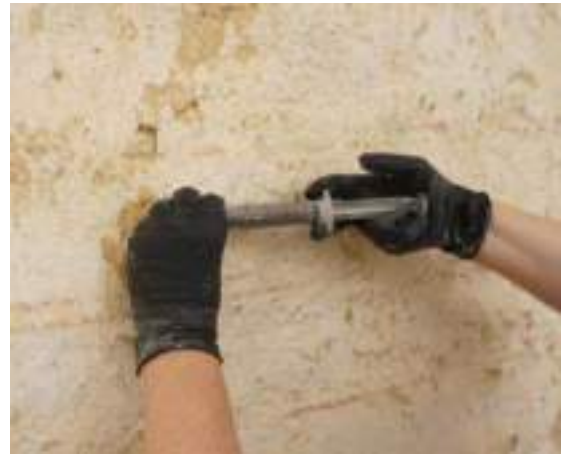
Introduction de l'éthanol coupé, puis du coulis de chaux par injection à la seringue
