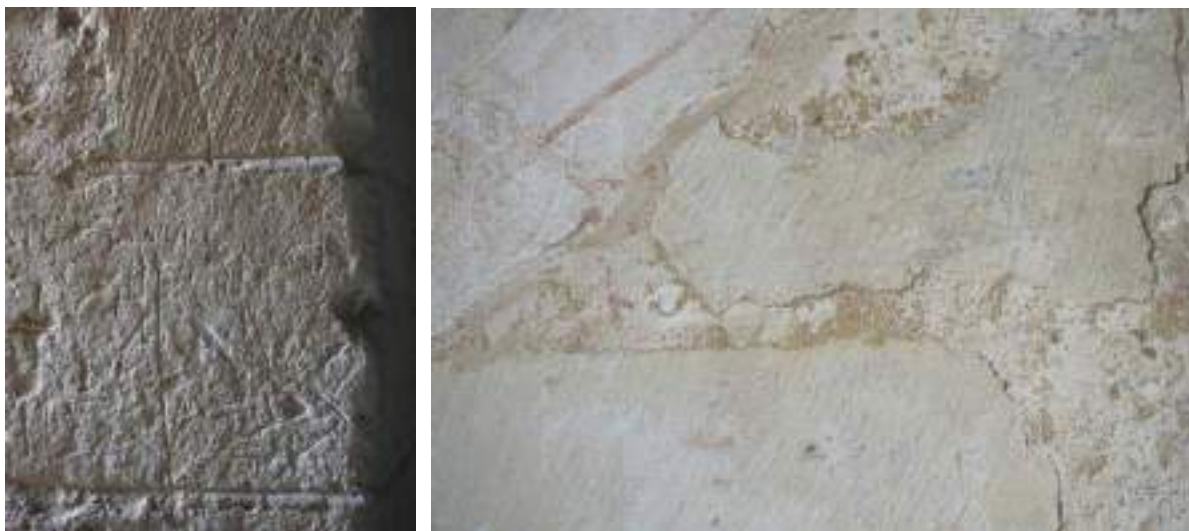
Salle du premier étage : détails des joints en bâtière de la baie et beurrés de la partie supérieure des murs
