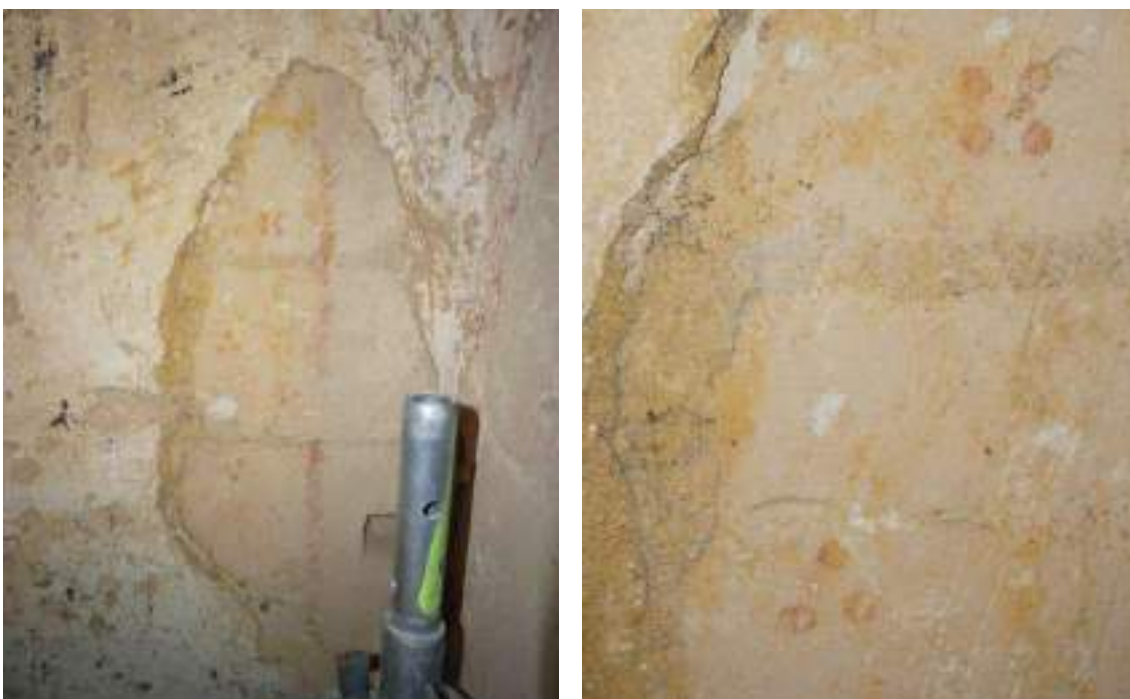
Vue générale et détail de la lacune de l'enduit du décor 2, sur laquelle passe la couche picturale du décor 3 – après dépoussiérage
