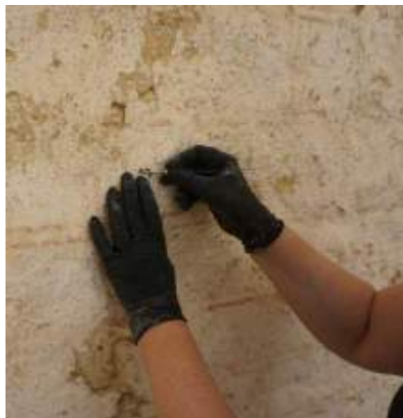
Nettoyage du point d'accès, recherche de la voie d'injection et mise en place d'une aiguille
