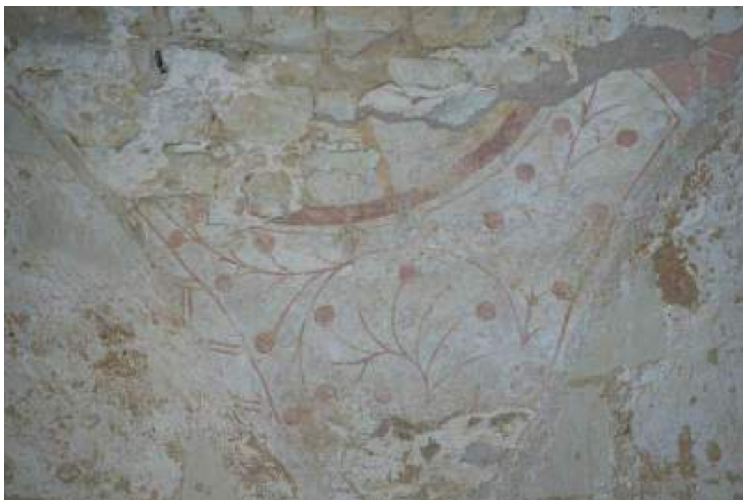
Vue générale d'application de mortier, en solin ou colmatage, sur le pendentif nord-ouest
