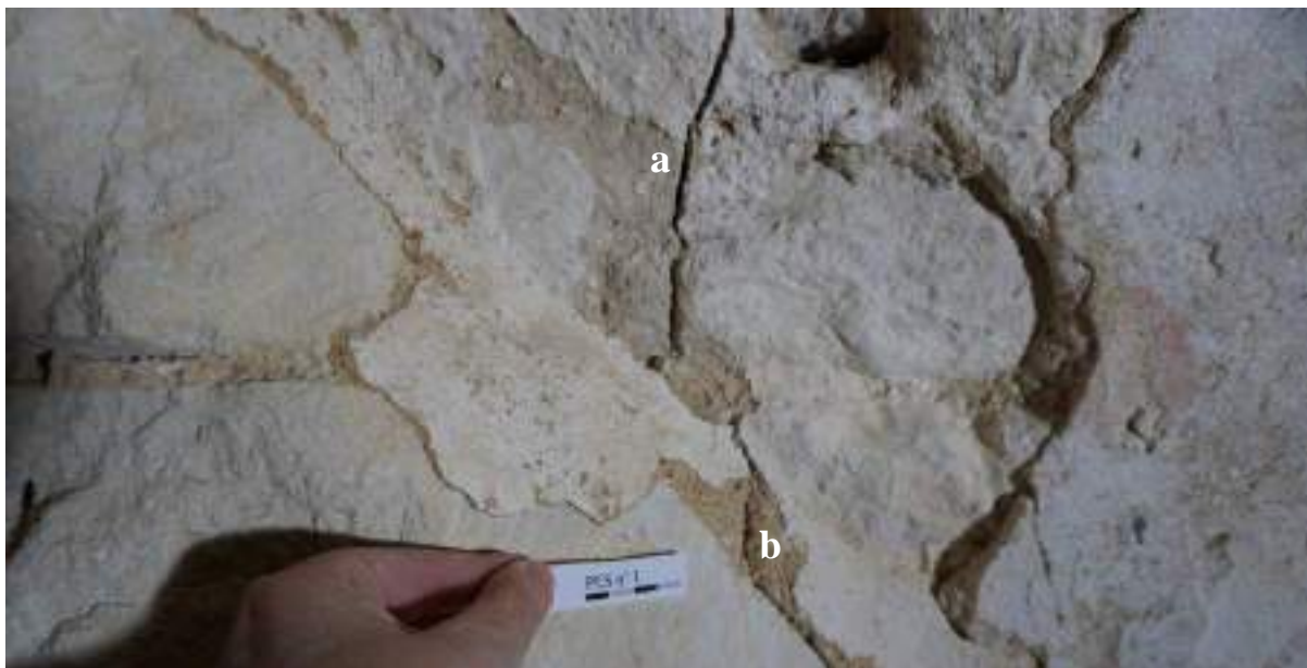
Détail des différents enduits à la jonction entre mur droit et pendentif
