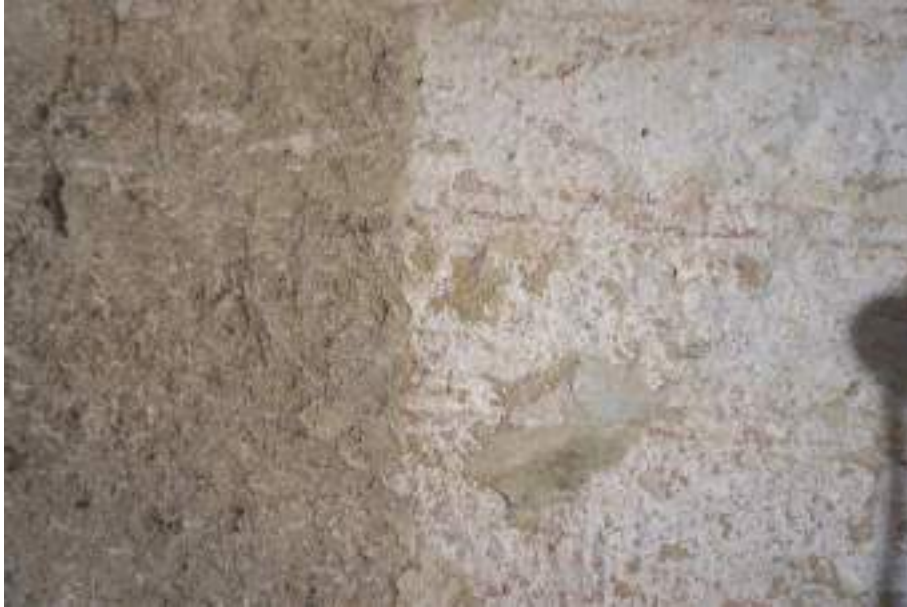
Détail de la couche de poussières en cours de dépoussiérage
