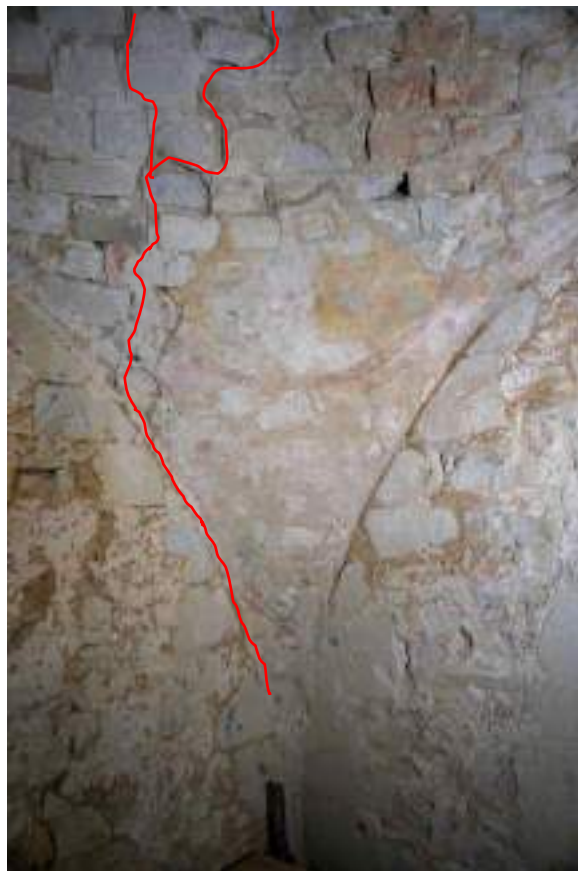
Vue générale de la partie sud de la coupole et du pendentif sud-est où une fissure du couvrement se poursuit dans le pendentif et le long de l'arc formeret du mur oriental
