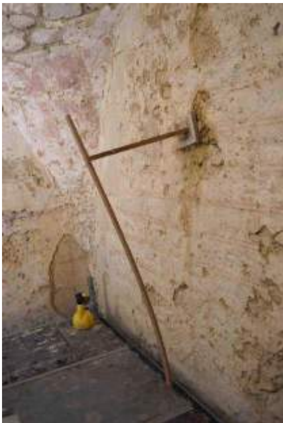
Mise sous presse étagée pendant la prise du consolidant
