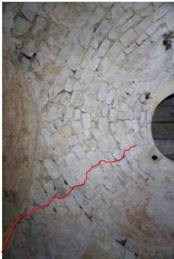
Vue générale de la partie sud de la coupole et du pendentif sud-est où une fissure du couvrement se poursuit dans le pendentif et le long de l'arc formeret du mur oriental
