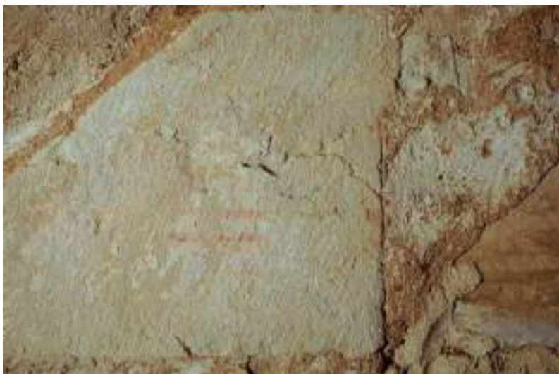
Exemple d'une zone où les lacunes sont profondes, de la couleur comme du badigeon, mettant à nu la pierre ou l'enduit
