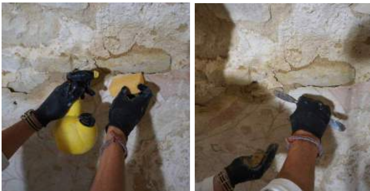
Humification de la zone à traiter et application de mortier à la spatule pour faire un solin
