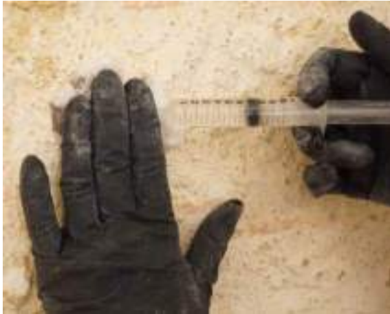
Introduction de l'éthanol coupé, puis du coulis de chaux par injection à la seringue
