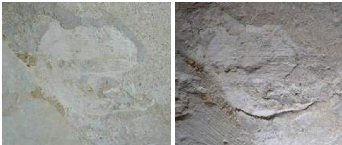
Détails, en lumière incidente et tangentielle, d'une lacune mettant au jour l'enduit du couchis. Sur le cliché en lumière rasante les fibres du bois des planches sont bien visibles
