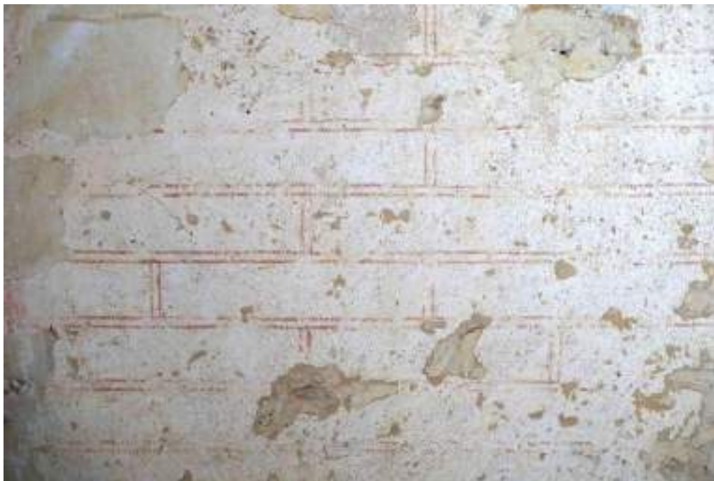
Détail du décor couvrant de faux appareil de pierre sur le mur oriental – après intervention
