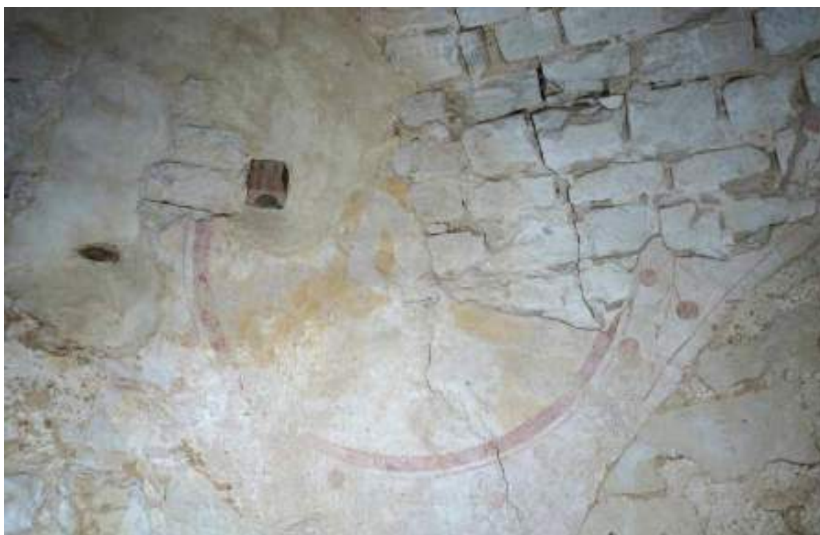
Vues générales des vestiges médaillons sud, est et ouest – après intervention
