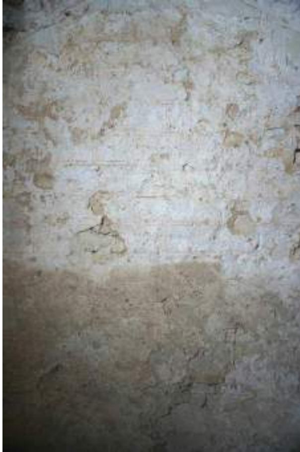
D détail du mur est en cours de dépoussiérage
