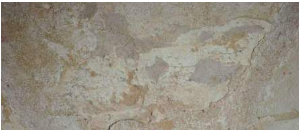
Détail du cliché précédent montrant l'application de mortier sur l'enduit de couchis de la première campagne
