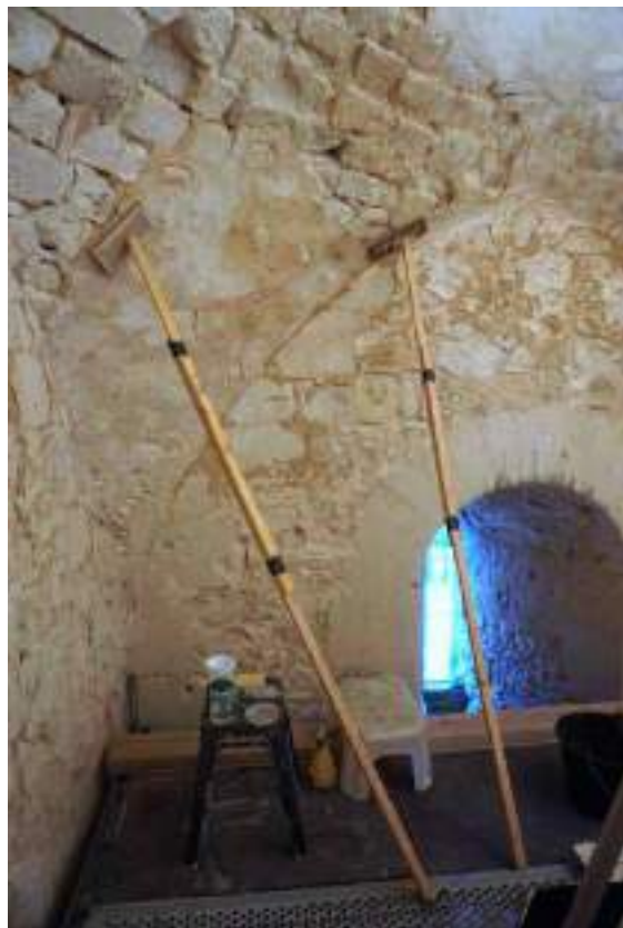
Mise sous presse étagée pendant la prise du consolidant
