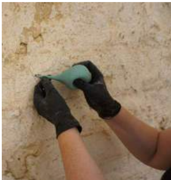
Nettoyage du point d'accès, recherche de la voie d'injection et mise en place d'une aiguille
