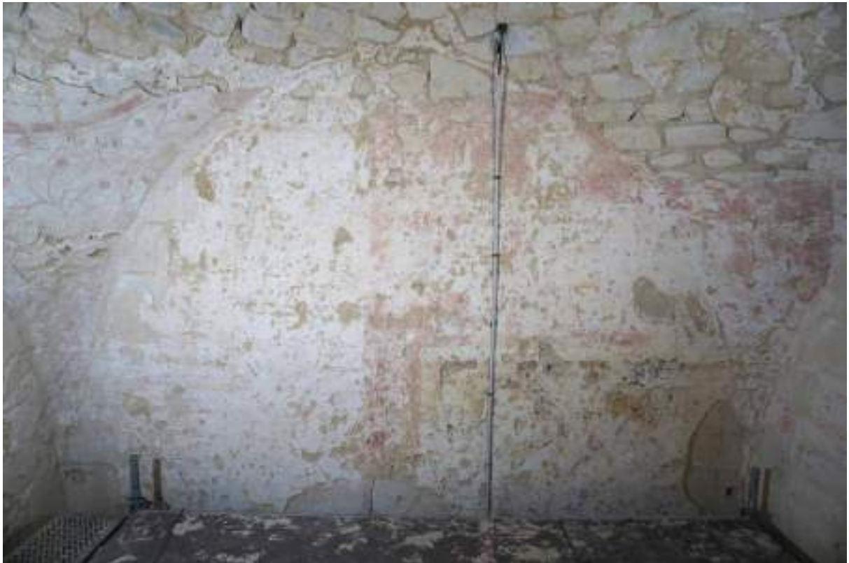
Vue générale de la partie supérieure des vestiges de la composition de la troisième campagne - après intervention
